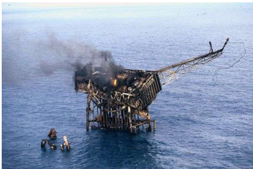
Figura II.14 - Parte do módulo “A” da plataforma Piper Alpha foi a única estrutura que restou acima da superfície após o desastre. (Fonte: DAILY RECORD, 2015)
