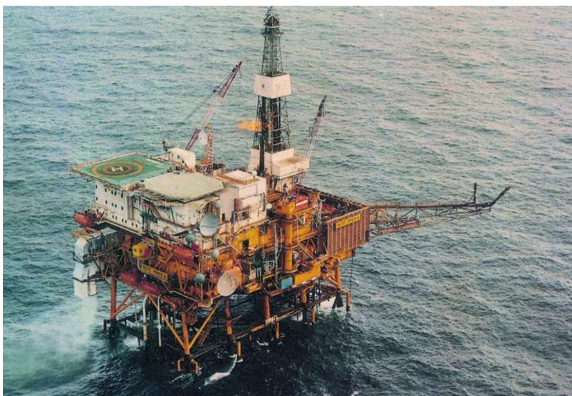
Figura II.3 - Plataforma Piper Alpha. (Fonte: ARABIAN OIL AND GAS, 2008).
