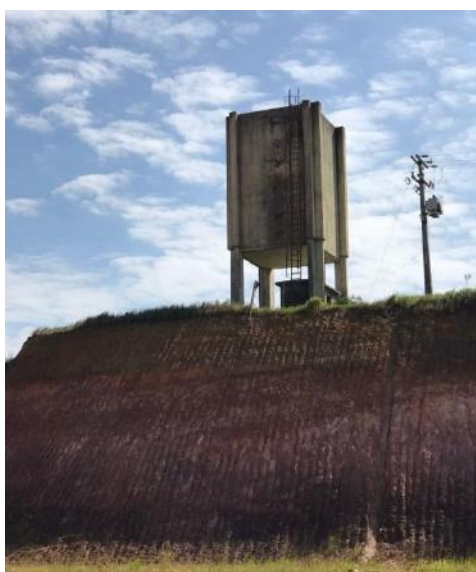
Figura 76 - Reservatório de água suspenso (Autor)
