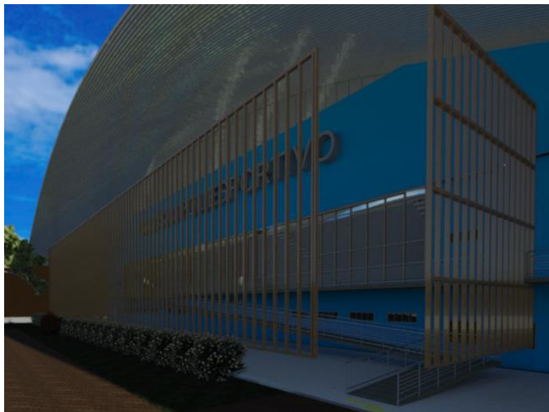
Figura 123 - Brise de madeira de reflorestamento (Autor)
