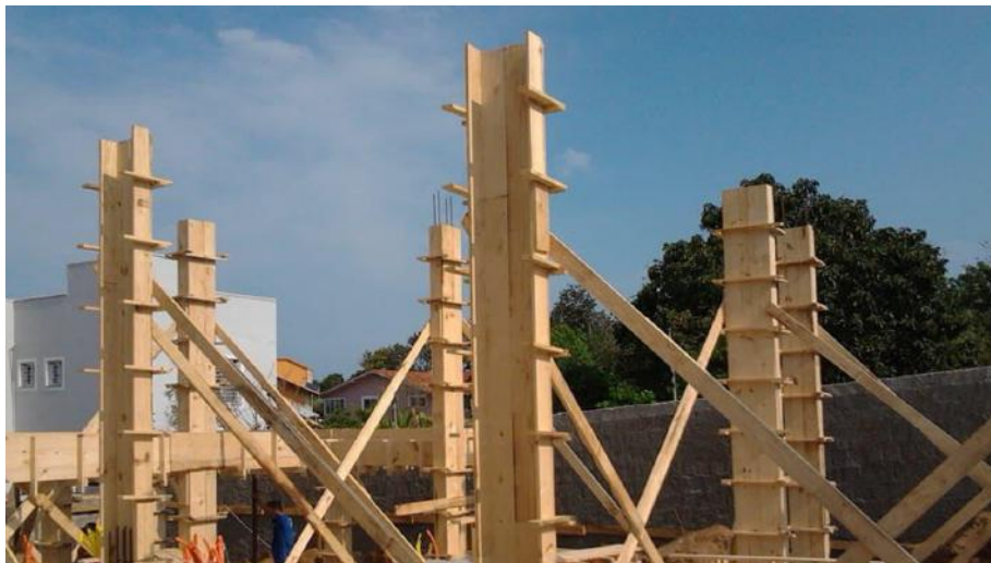
Figura 44 - Formas de madeira para pilares. (Fonte: Google, 2023. https://construindocasas.com.br/blog/dicas/como-calculer-a-quantidade-de-madeiras-para-caixarias/ )
