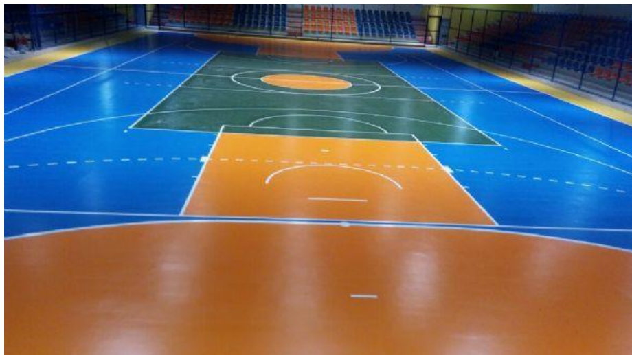
Figura 81 - Quadra poliesportiva com pintura no piso (Fonte: Canal ecológico, 2023)
