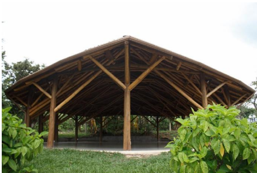
Figura 39 - estrutura feita em bambu. (Fonte: Google, 2018. http://tecnicaparaconstrucaosustentavel.blogspot.com/2015/12/neste-post-apresentamos-o.html )
