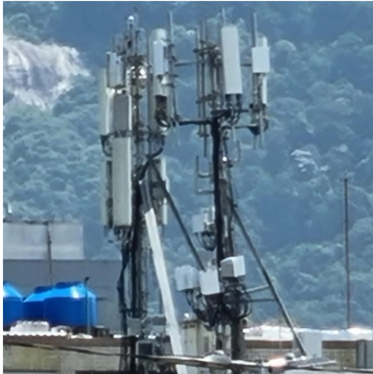
(Figura 6) – ETR na Avenida Delfim Moreira em 2021 – Fotografia.
