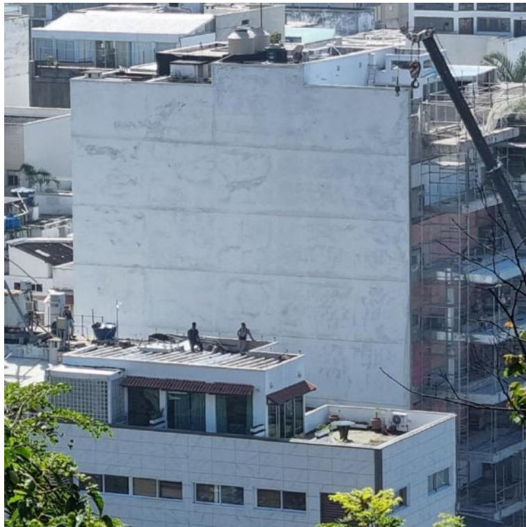
(Figura 7) – ETR sendo retirada na Avenida Delfim Moreira em 2022 – Fotografia.
