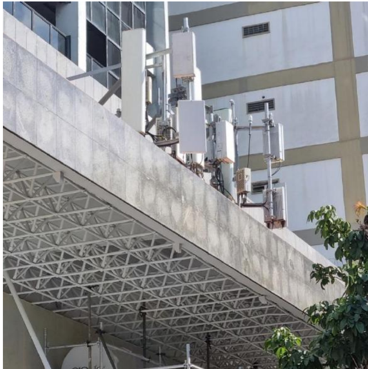
(Figura 13) – ETR na Rua Visconde de Pirajá em 2022 – Fotografia.
