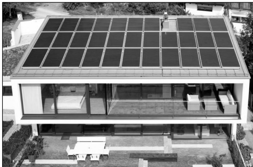
Figura 32 – Solução aditiva para instalação de módulos FV
