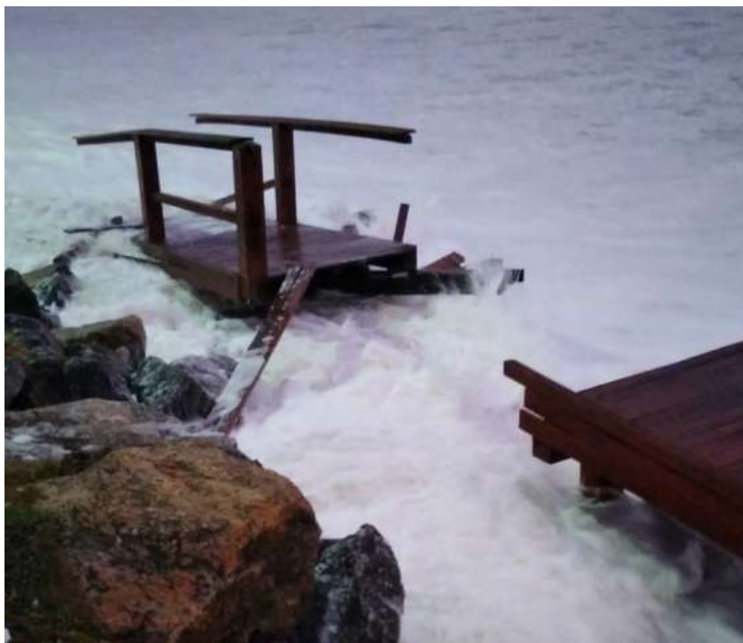
Foto 6: Calçada destruída na Barra de Maricá após a ressaca de julho de 2021. (Fonte: MARICÁ INFO)
