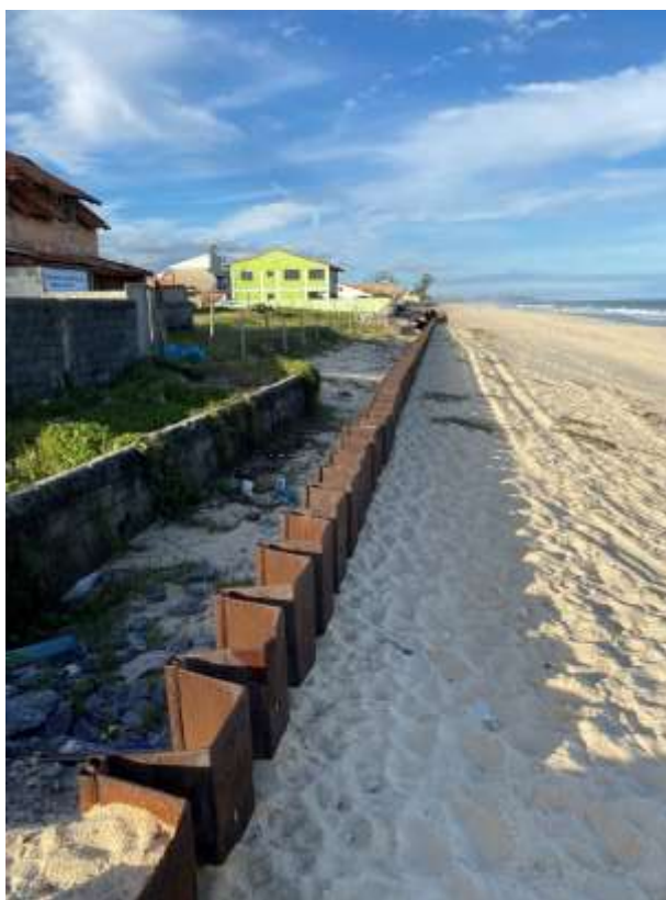
Foto 14: Estacas-prancha instaladas pela prefeitura na praia de Cordeirinho, entre as ruas 61 e 65, na tentativa de diminuir os processos erosivos na área. Fonte: De autoria própria (2023).
