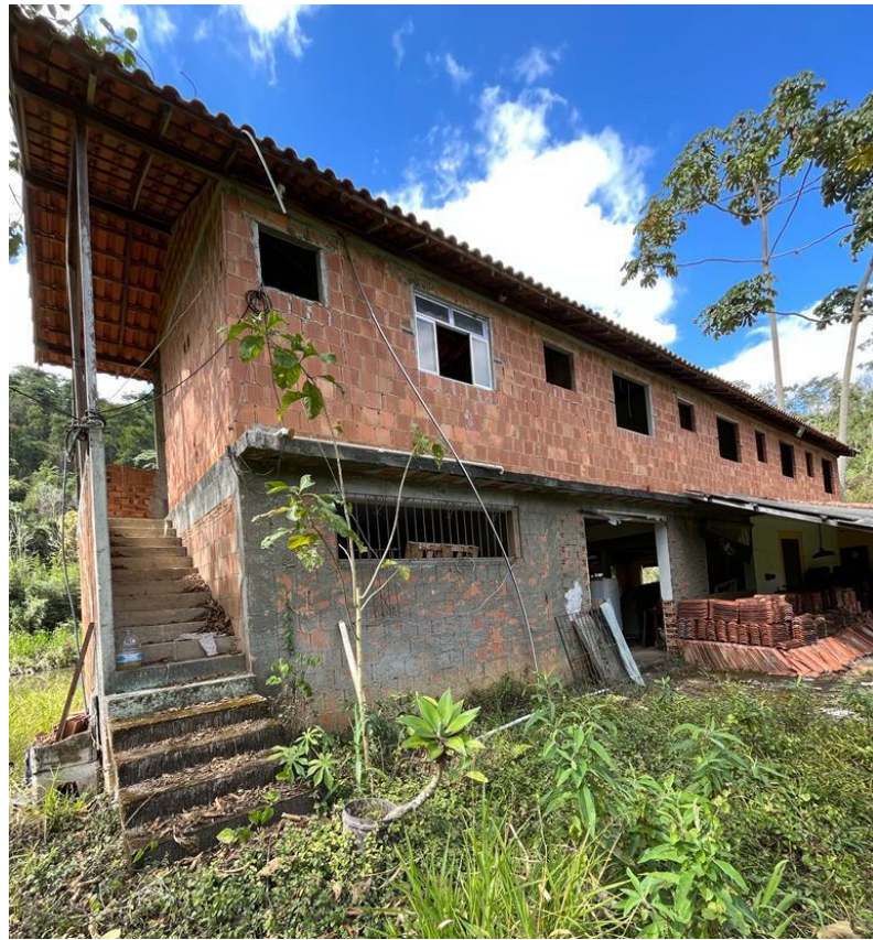
Figura 32 Empreendimento antes da finalização da obra (Autora)
