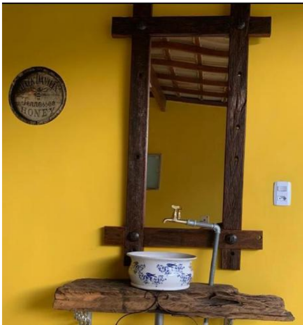
Figura 47 Bancada em madeira de dormentes e moldura em madeira de cruzetas (Fonte: ECOTRAL)
