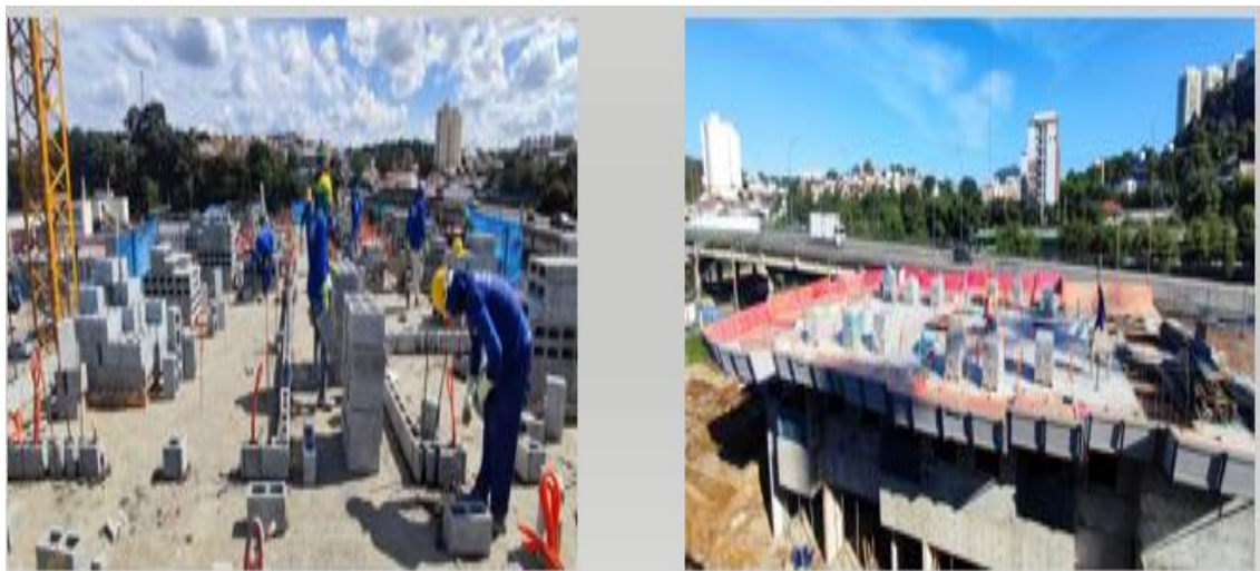
Figura 25 – Alvenaria: Antes x Depois
