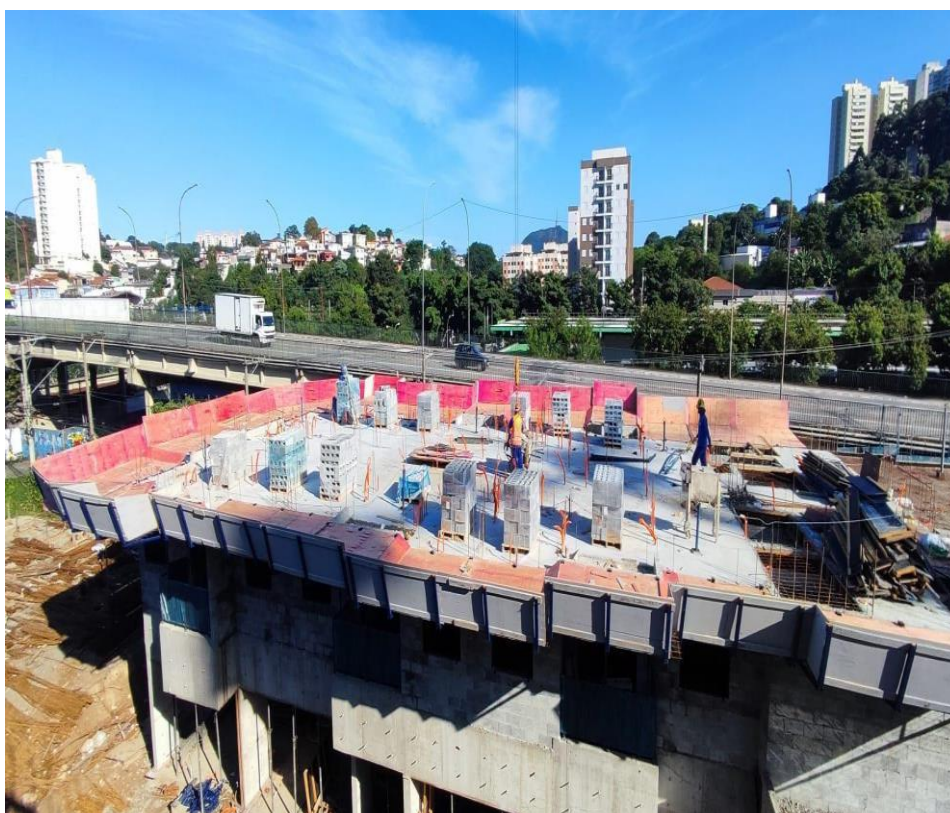
Figura 13 – Vista da laje com os paletes de bloco
