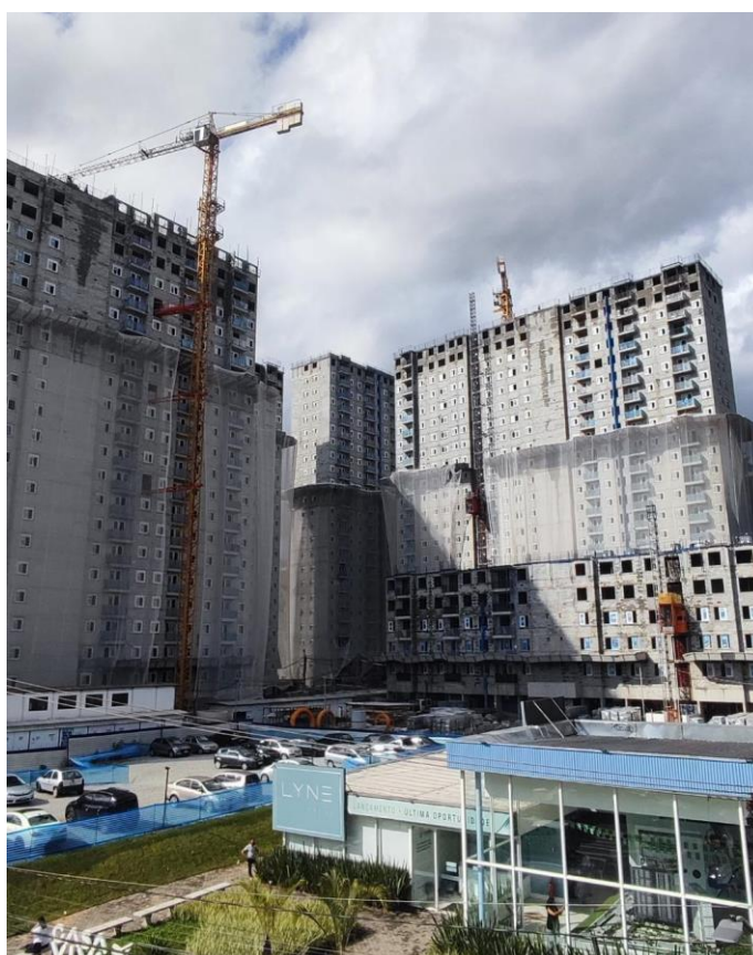
Figura 12 – Vista do canteiro de obras
