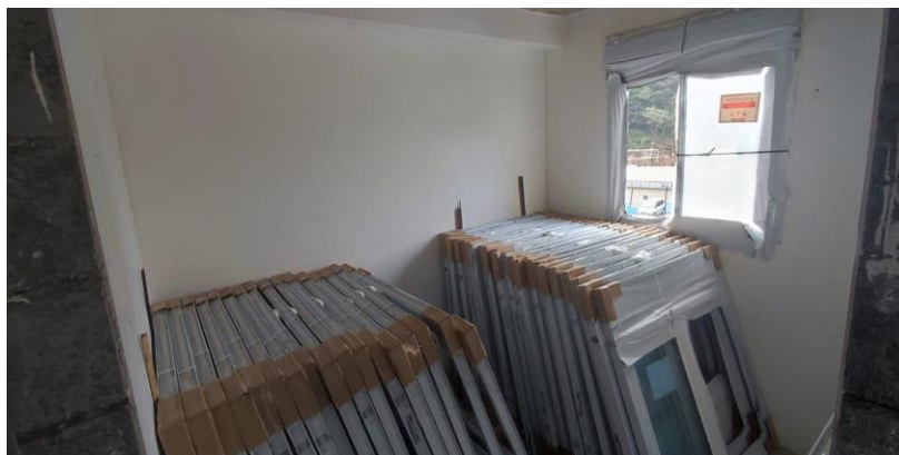
Figura 19 – Armazenamento de caixilhos
