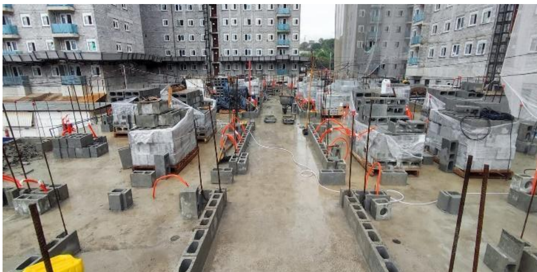
Figura 14 – Marcação da 1ª fiada de blocos
