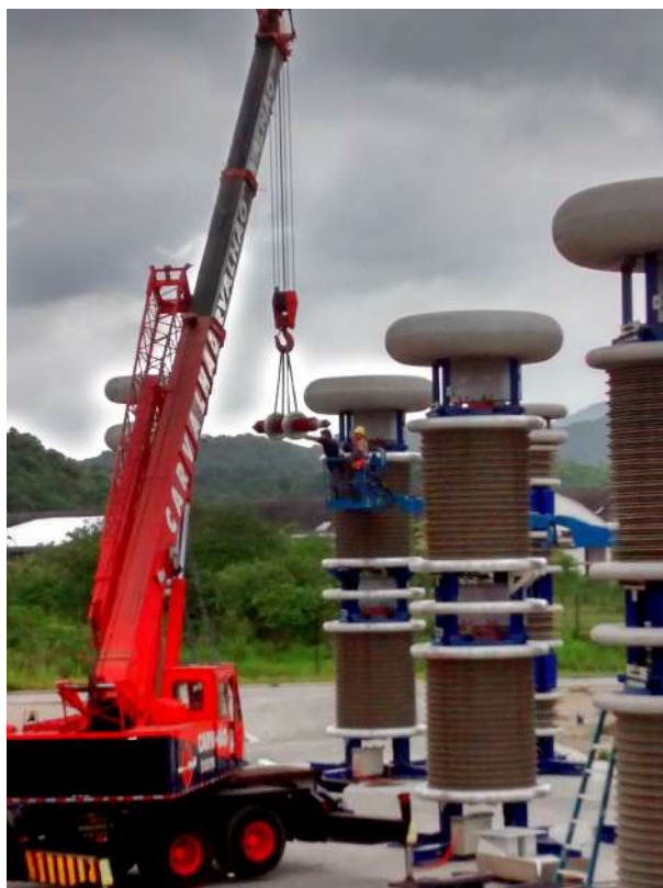
Figura 3.3: Içamento com auxílio de guincho e plataforma aérea.
