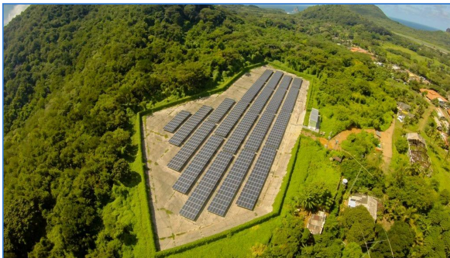
Figura C.3 – Visão geral da UFV Noronha II Fonte: (AULAS DE ENERGIA 18 , 2018)
