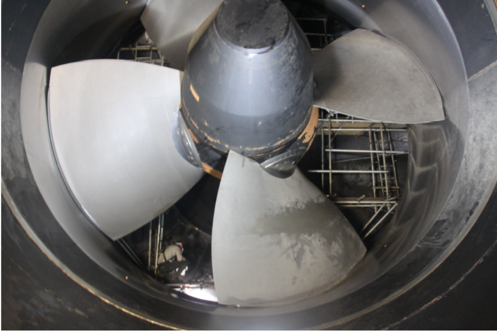
Figura 1.5: Turbina da Usina Hidrelétrica de Jirau [2].
