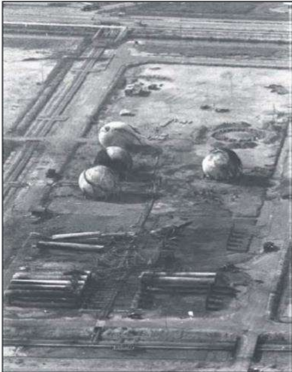
Figura 4.3 - Parque da REDUC destruído após seqüência de explosões
