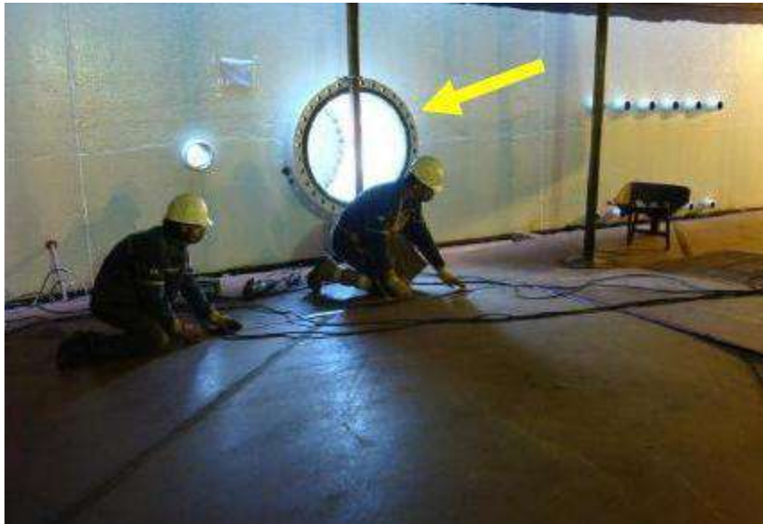
Figura 4.10: Bocas de Visita
