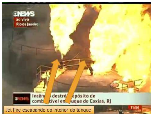
Figura 7.8: Jet-Fire acima dos tanques Fonte: Globo News
