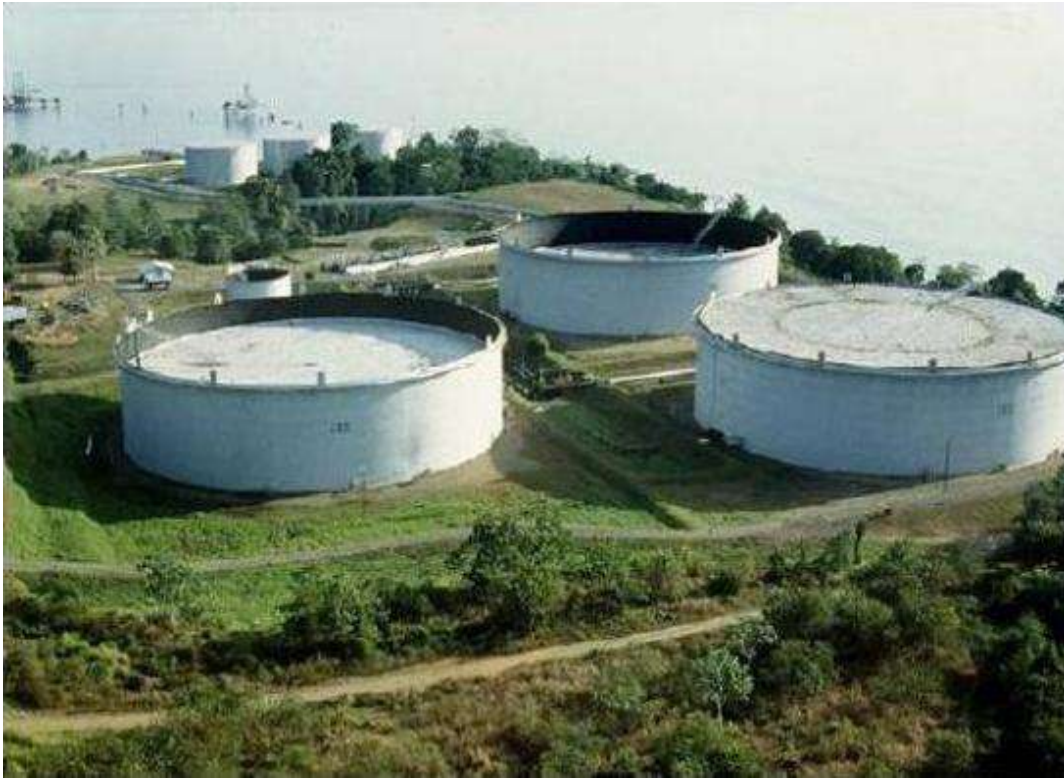
Figura 4.3: Tanques de Teto Flutuante Externo
