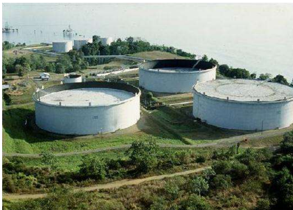
Figura 3.1: Tanques de teto flutuante Fonte: Marco, 2010.
