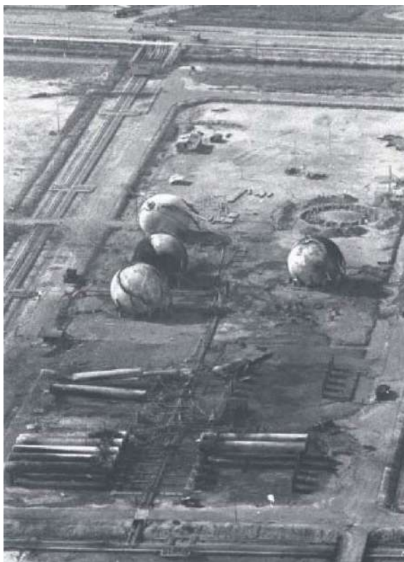
Figura 4.3: Esferas de GLP após o acidente Fonte: Puiatti, R. 2011.
