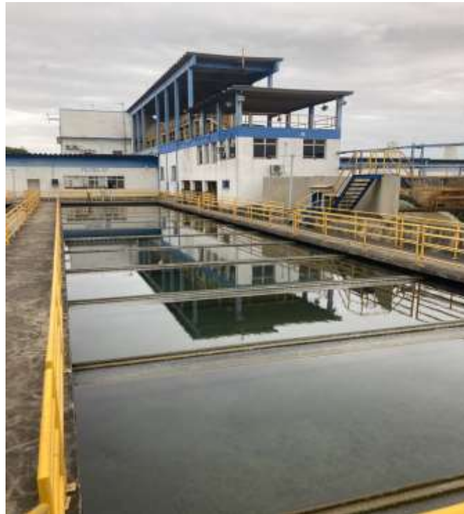
Figura 07: Parte da estrutura do Sistema Imunana-Laranjal/RJ
