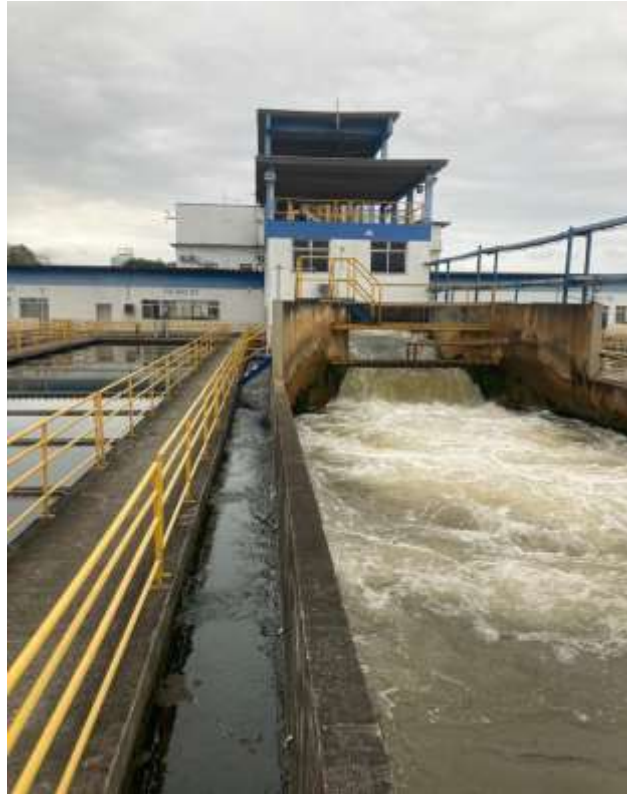
Figura 08: Parte da estrutura do Sistema Imunana-Laranjal/RJ
