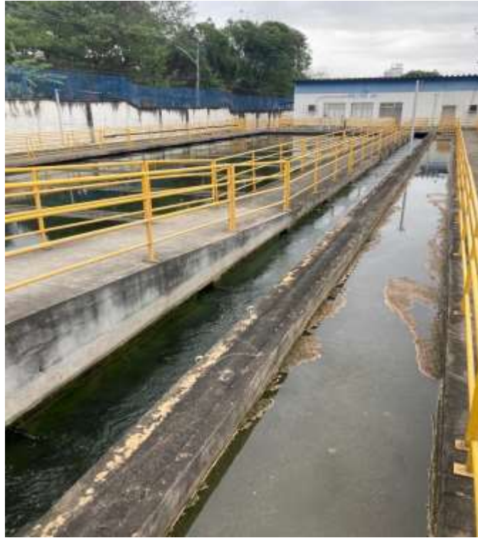
Figura 06: Parte da estrutura do Sistema Imunana-Laranjal/RJ
