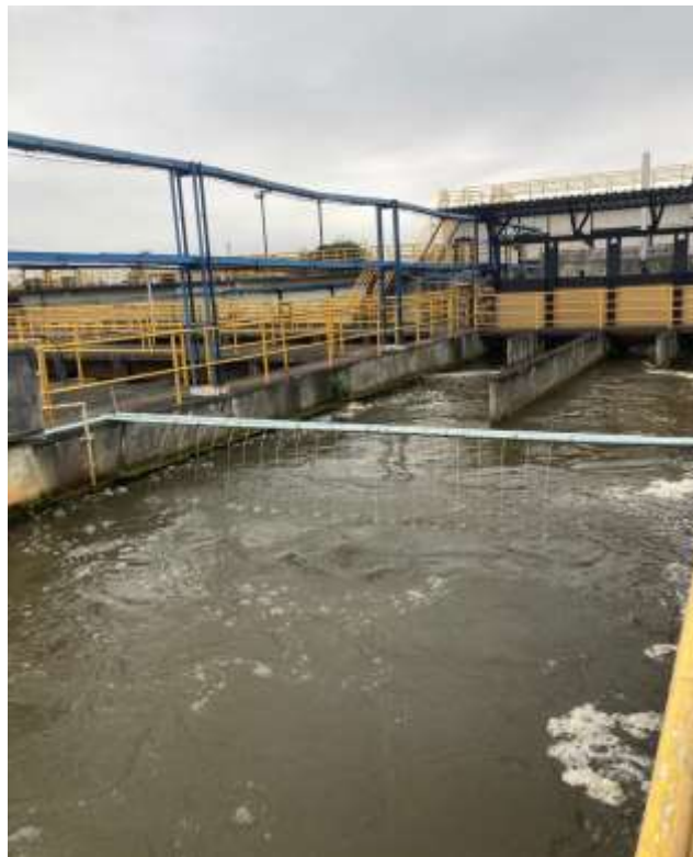
Figura 09: Parte da estrutura do Sistema Imunana-Laranjal/RJ
