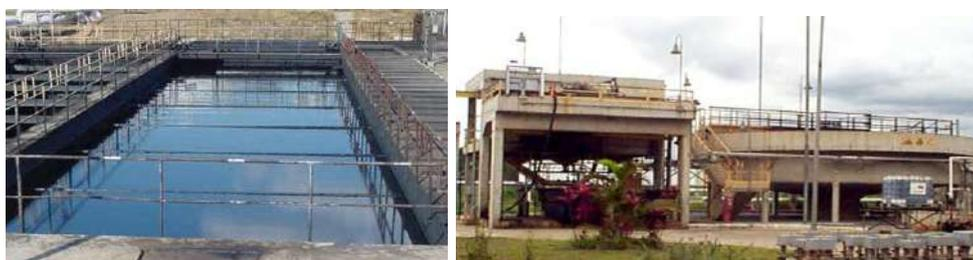
*Figura 8. Tratamento Primário de Efluentes Hídricos: Separação água/óleo e Flotação*
