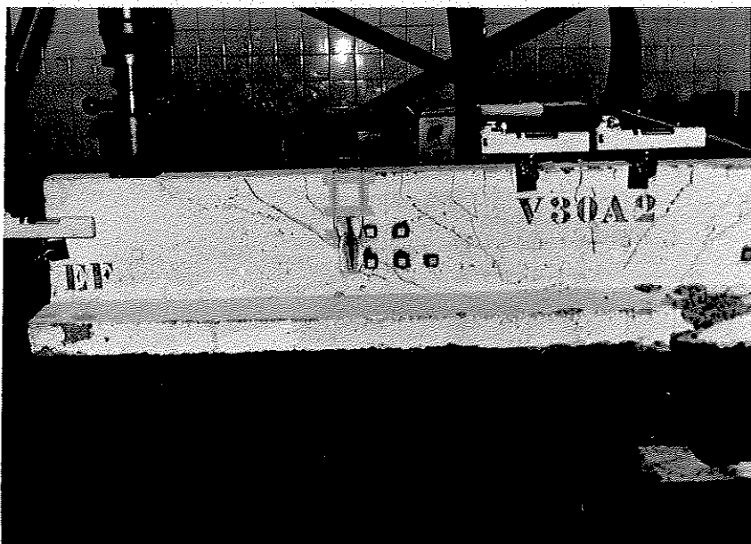
Foto A.4 - Lado esquerdo da viga V30A* com a armadura transversal em escoamento.
