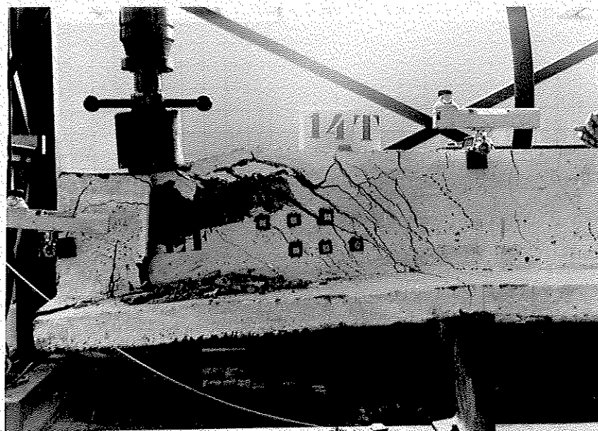
Foto A.10 - Lado esquerdo (frente) da viga V25B* rompida por esforço cortante.
