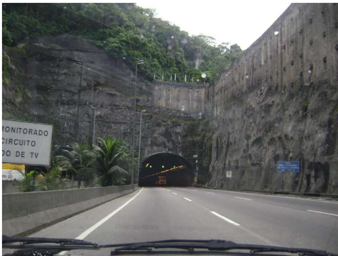
Figura 7 – Túnel da Covanca, 2020
