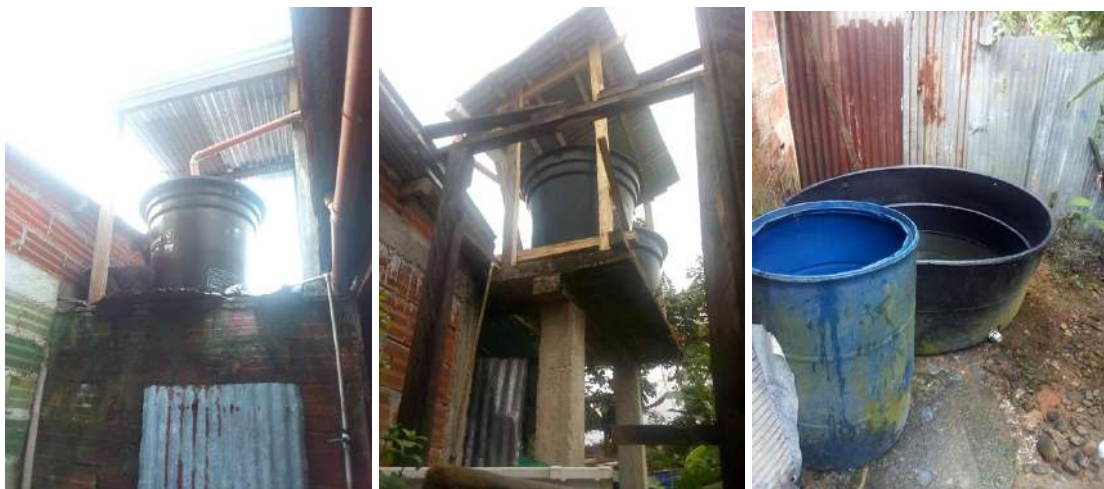
Figura 18 - Sistemas de captação de água chuva encontrados na comunidade.
