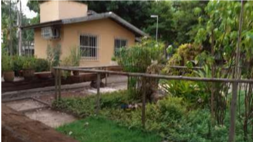
Guarda-corpo na área visitação (Fonte: in loco)
