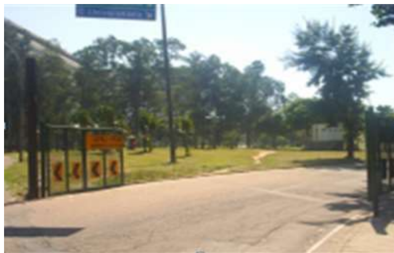
Figura 59 - Exemplo de portão de controle de acesso ao Campus
