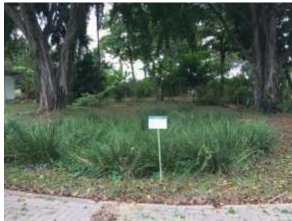
Jardim de chuva e sistema de drenagem ao longo das vias internas para facilitação da drenagem (Fonte: in loco)
