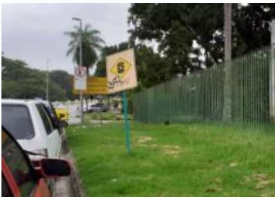
Figura 81 - Exemplo de placa de sinalização danificada
