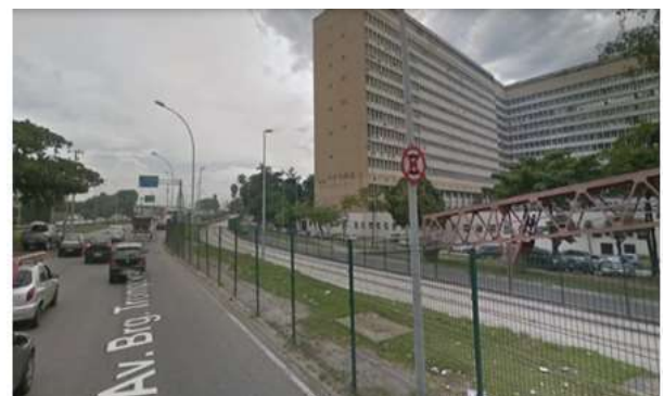
Figura 62 – Intervenções com impacto nos
