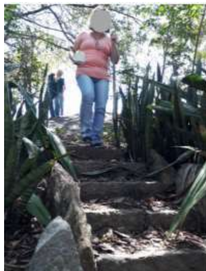
Ausência de guarda-corpo em pontos de interesse (Fonte: in loco)
