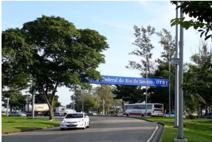
Figura 68 - Exemplo de pórtico instalado nos acesso do Campus – exemplo acesso 2
