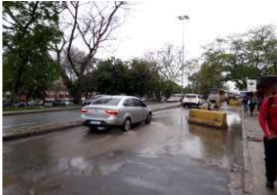
Figura 83 – Exemplo de elemento ordenador de fluxo de fluxo de veículos precário
