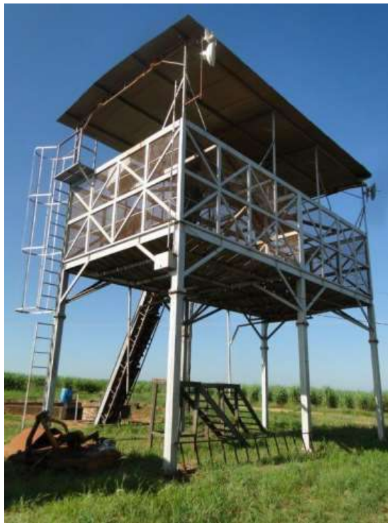
Figura 10: Silo tipo Bin
