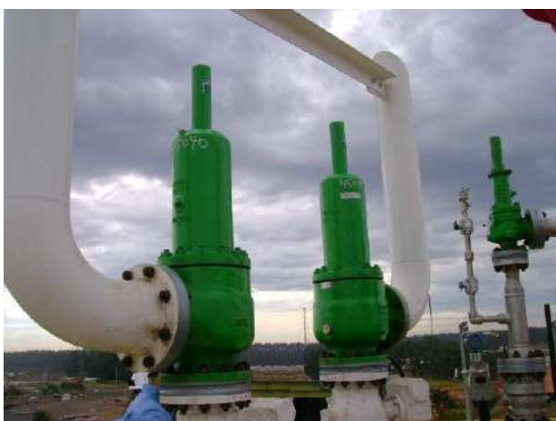
Figura III-1 – PSV's alinhadas para o meio ambiente (à frente) e para a tocha (ao fundo)
