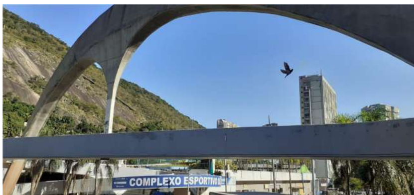
Figura 1 - Passarela da Rocinha
