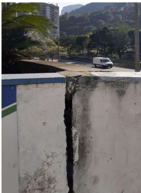
Figura 2 - Passarela rachada.
