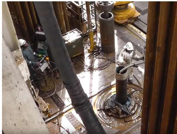
Figura 3.5 – Bombeamento de fluido no interior da coluna de revestimento [84]
