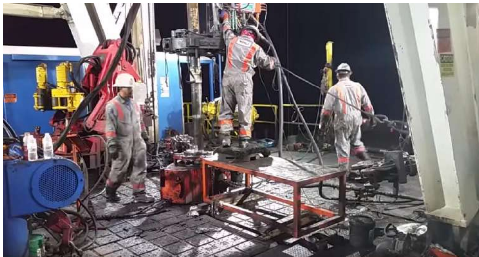
Figura 3.3 – Montagem da coluna de revestimento [84]
