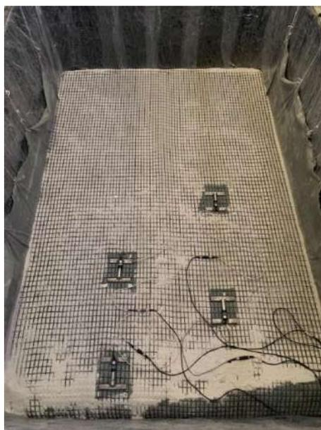
Figura 3.27 – Instalação da 2ª camada de reforço geossintético.
