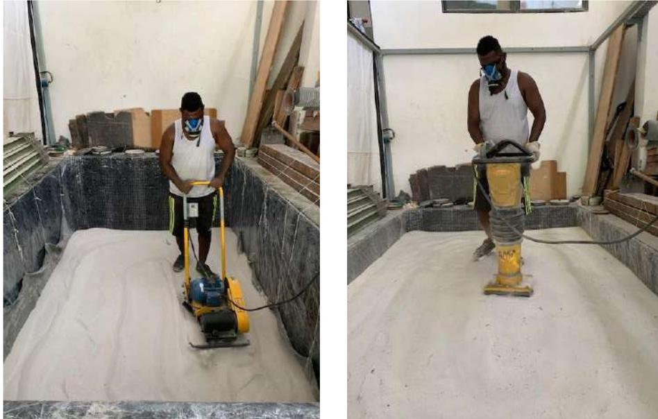
Figura 3.26 – Compactação do aterro com: (a) placa vibratória; e (b) soquete vibratório.
