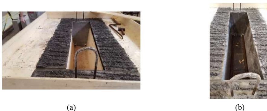
Figura 5.24 – Retirada da forma superior: (a) Retirada em andamento, com superfície escarificada exposta e (b) Retirada total e verificação da passagem dos tirantes.
