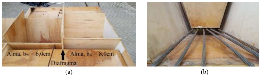
Figura 5.5 – Inserção de diafragma na forma: (a) divisão do comprimento, (b) passagem das cordoalhas.
