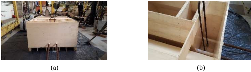
Figura 5.21 – Fixação dos laços de ancoragem: (a) Vista frontal e (b) Vista lateral.
