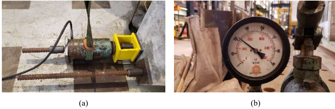
Figura 5.34 – Procedimento de protensão: (a) alternância de barras e (b) verificação do manômetro.
