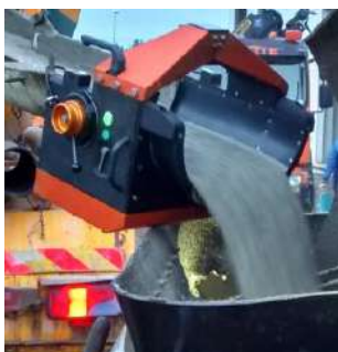
Figura 2.6 – Controle do concreto misturado na betoneira [71].
