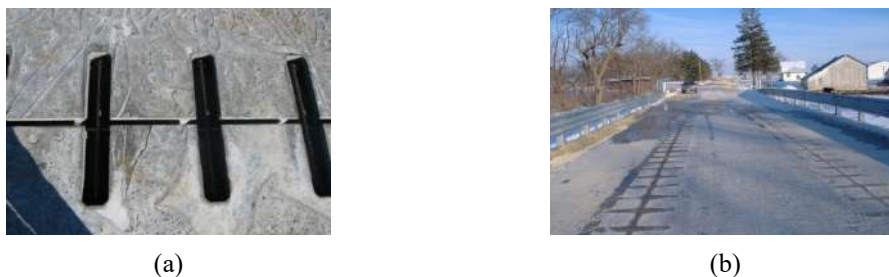
Figura 4.5 – Juntas de conexão: (a) Armadura transversal inserida e (b) Superfície acabada [234].
