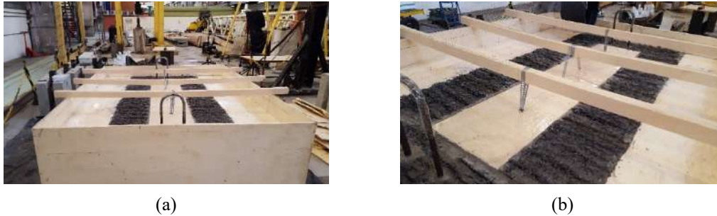
Figura 5.25 – Instalação da forma perdida: (a) Vista Frontal e (b) Vista Lateral.
