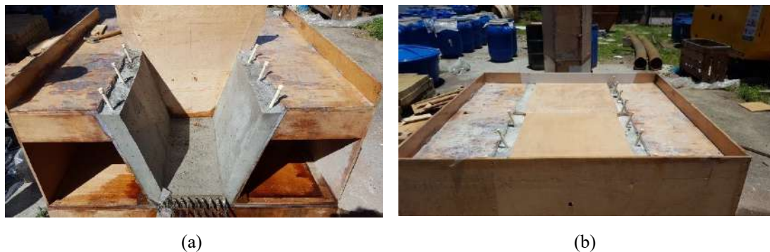
Figura 5.10 – Desmolde parcial do protótipo: (a) retirada da forma superior após 48 horas e (b) instalação da forma perdida.
