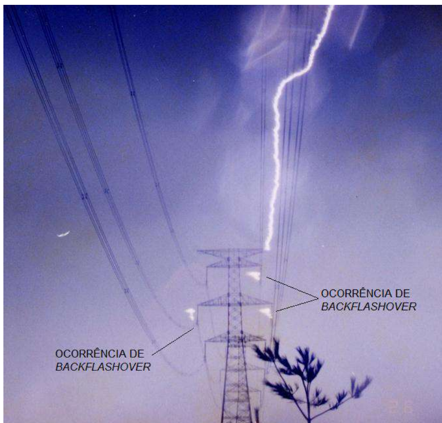
Figura 2.6-3 – Momento de Ocorrência do Backflashover (Adaptada de [16])
