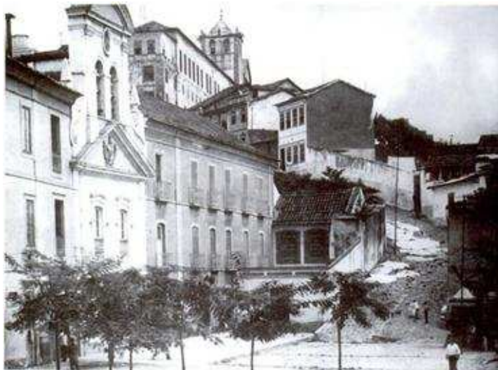
Figura 1 - No alto do Morro do Castelo, está a igreja de Santo Inácio, e no sopé a Igreja de Nossa Senhora do Bonsucesso
