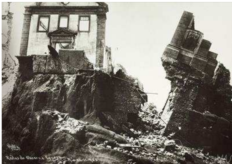
Figura 4 - Demolição do Morro do Castelo e da Igreja dos Jesuítas
