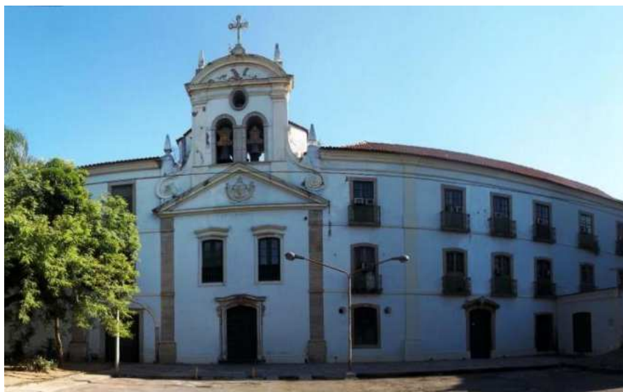
Figura 5 – Fachada da Igreja Nossa Senhora do Bonsucesso
