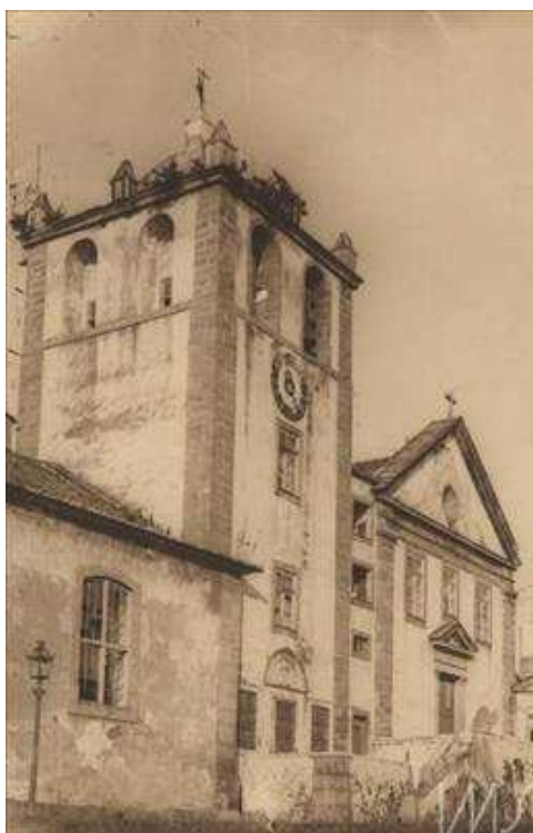
Figura 2 - Fachada da Igreja dos Jesuítas em 1918
