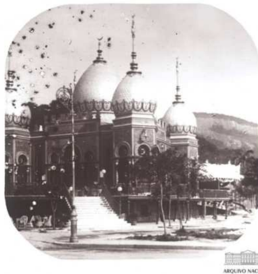
Figura 35. Pavilhão Mourisco em 1908.
