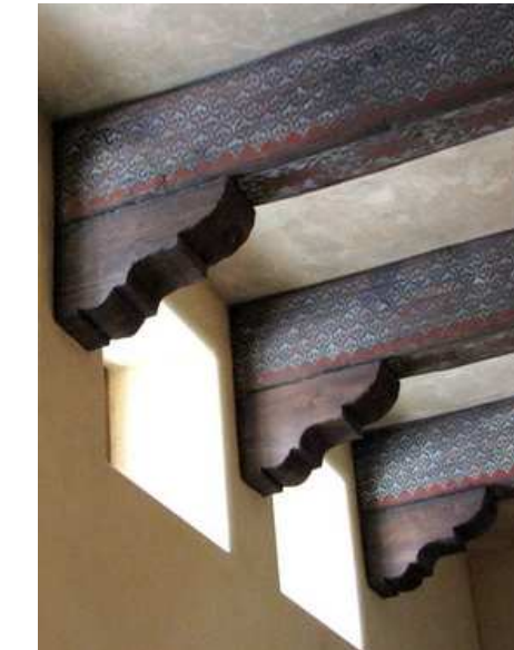
MARCAÇÃO DO TETO COM VIGAS
