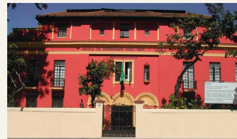
Intervenções nas fachadas (elementos na janela)
