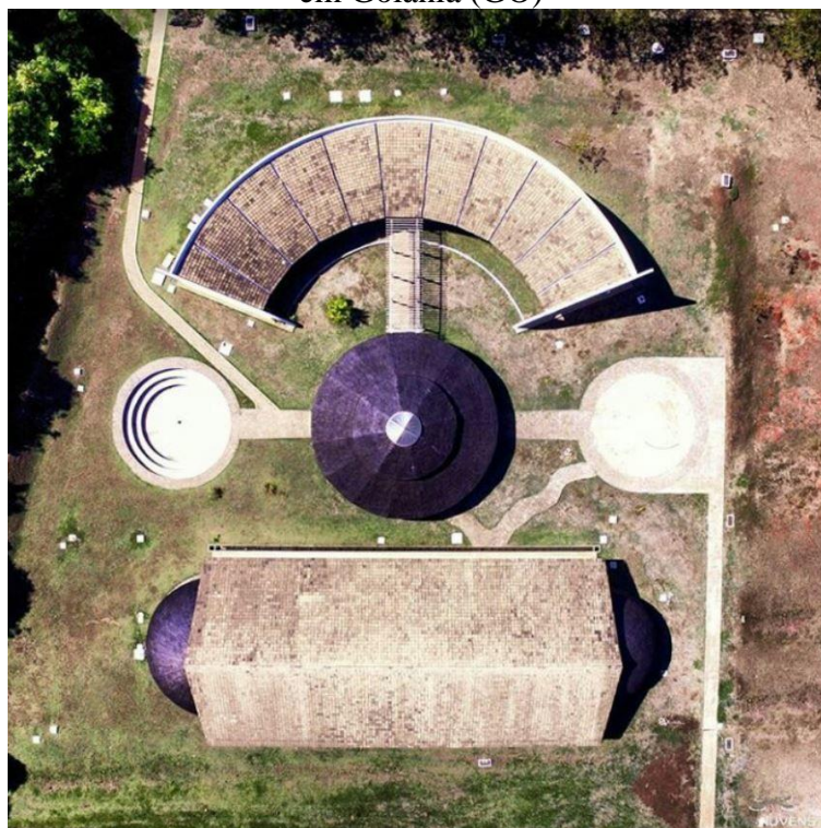
Figura7: Vista aérea do Núcleo Takinahakỹ da Universidade Federal de Goiás (UFG), em Goiânia (GO)
