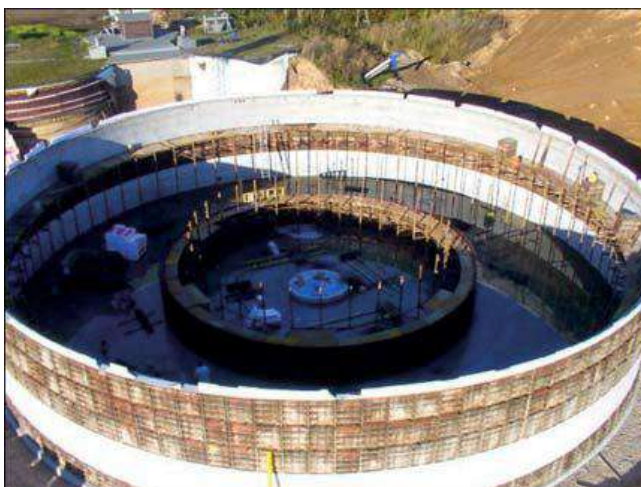
Figura 8: Construção de um biodigestor de concreto (LIEBETRAU, 2010).
