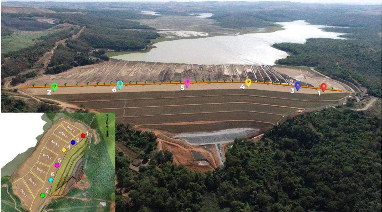
Figura 36: Vista aérea da Barragem BR de Catalão com a estrutura de espigotamento. Onde pode ser observado o espigotamento ocorrendo na Baia 5, entre o geofone 4 e 3.
