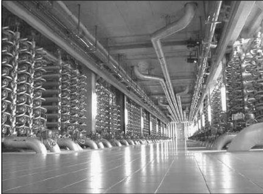
**Figura 2.2. Fotografia da planta de MF/NF em Mery-Sur-Oise, Paris (LI, 2008).**
