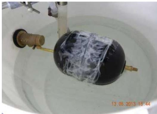
Figura 23: Conexão válvula de cisterna para controle nível do T2
