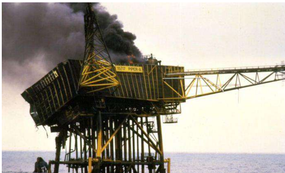
Figura V.7 – Destroços do módulo A da plataforma Piper Alpha (FONTE: www.assetstorage.co.uk , acesso em 15 de fevereiro de 2014)
