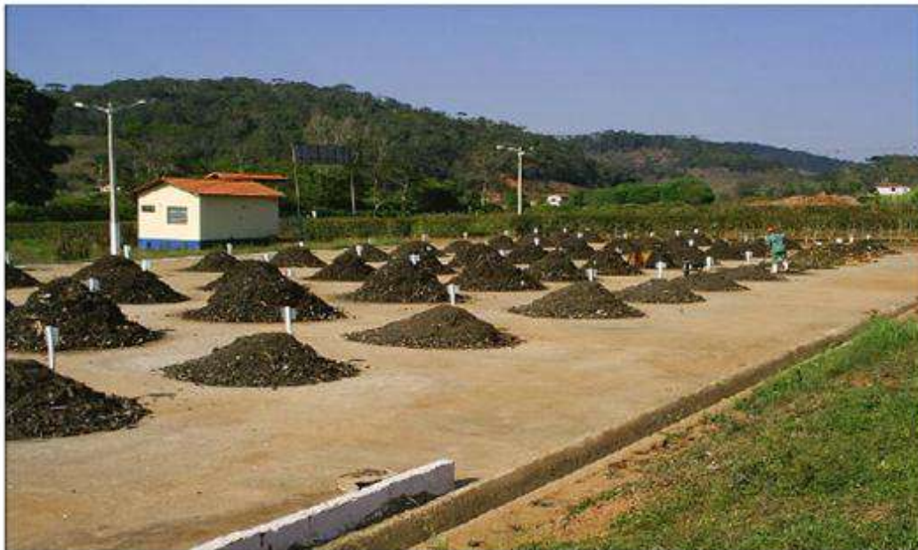
Figura 18: Unidade de Compostagem de Resíduos Orgânicos.
