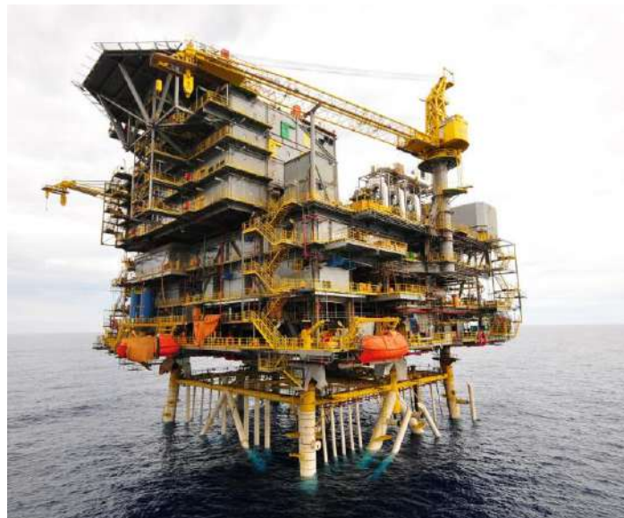
Figura 3: Plataforma de Mexilhão (PMXL-1) FONTE: Site Rio Grande Offshore
