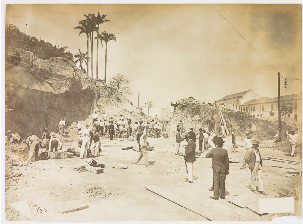
Figura 8: Início da demolição do Morro do Castelo, 1904, vendo-se à direita o Convento da Ajuda. Foto de João Martim Torres [acervo Instituto Moreira Salles]
