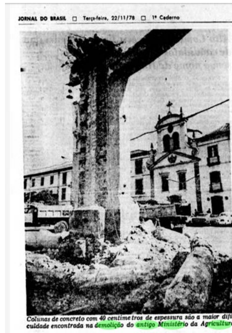
Figura 7: “colunas de concreto com 40 centímetros de espessura são a maior dificuldade encontrada na demolição do antigo Ministério da Agricultura” [Jornal do Brasil, 22/11/1978, p. 4]
