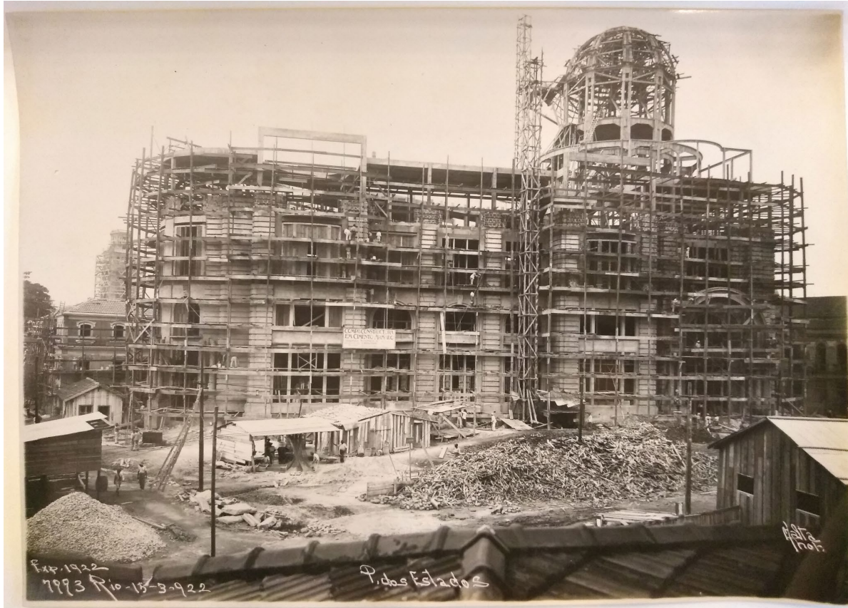
Figura 9: Construção do Palácio dos Estados da Exposição de 1922. Foto de Augusto Malta em 15/03/1922 [acervo Biblioteca Nacional]
