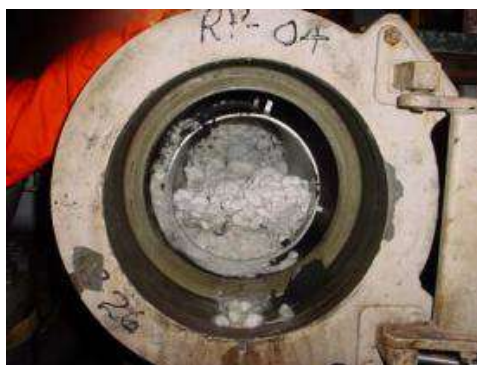
Figura 2.8 Hidratos Formados em um Tubulação do Campo de Namorado, na Bacia de Campos, RJ (Fonte: SANT'ANNA, 2005)
