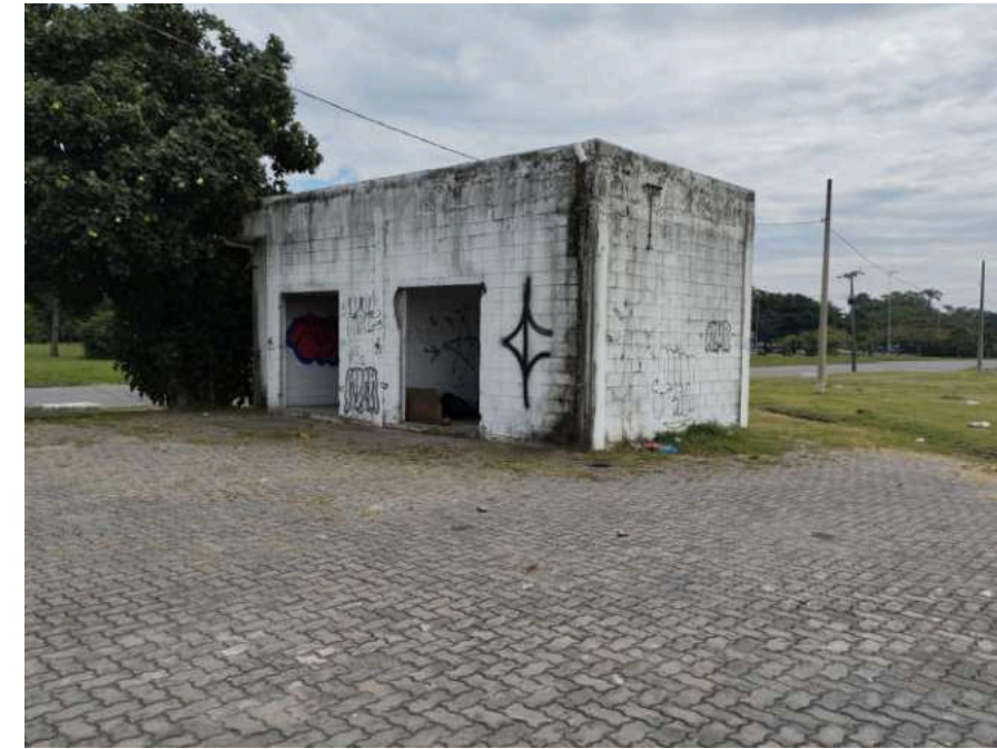
Visada 1: construção abandonada após a finalização do canteiro de obras em 2015
