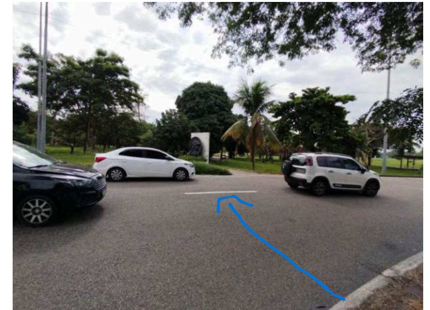
Visada 2: Travessia perigosa, utilizada como atalho para os pedestres
