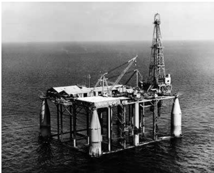
Figura 2.3: A plataforma Bluewater 1, primeira plataforma semissubmersível do mundo. Fonte: PRIEST, 2014
