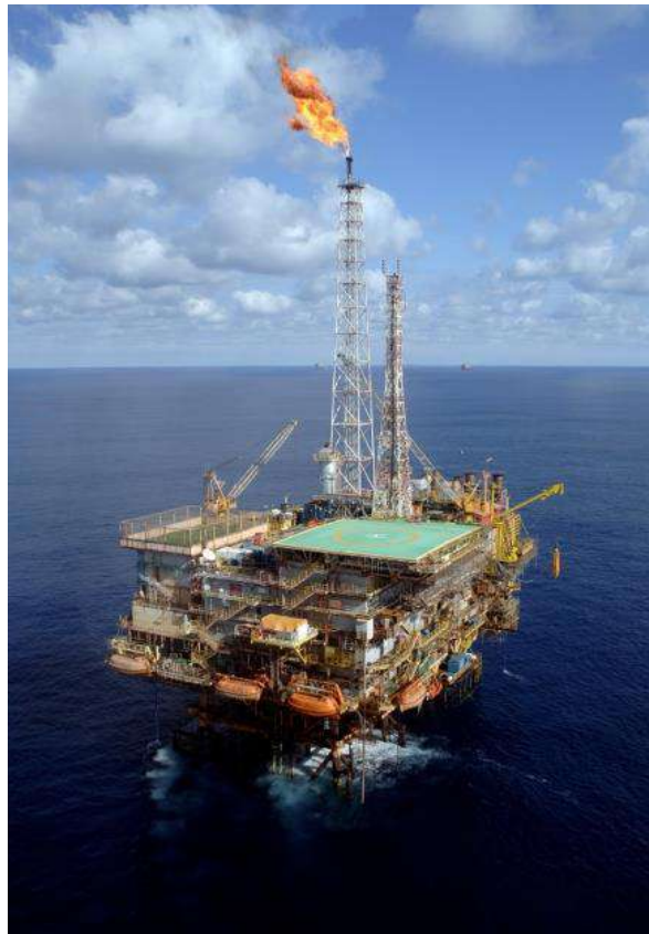
Figura 2.4: Plataforma de Garoupa operando na Bacia de Campos. Fonte: PETROBRAS, 2015b.
