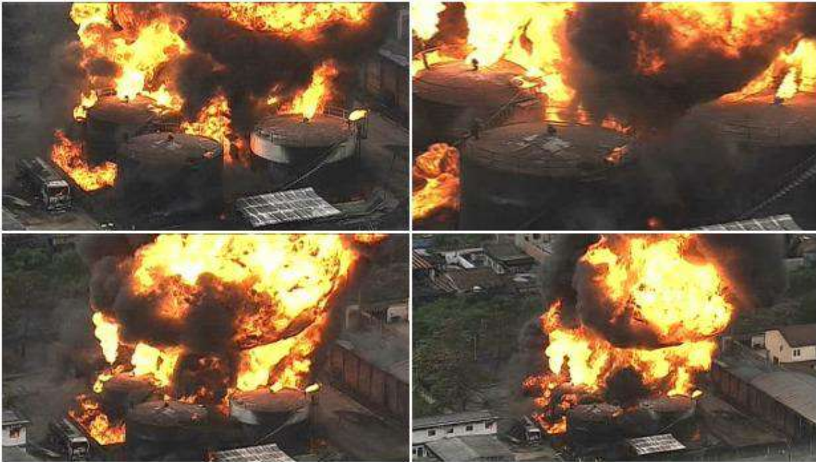
Figura 31 - Incêndio no dique da transportadora Petrogold.
