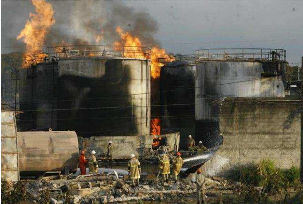
Figura 33 - Muro destruído durante o evento accidental.
