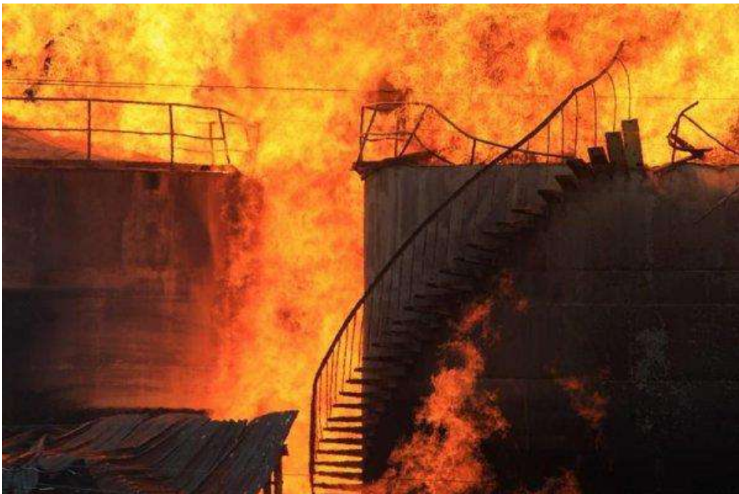
Figura 34 - Danos sofridos por estruturas próximas ao tanque.
