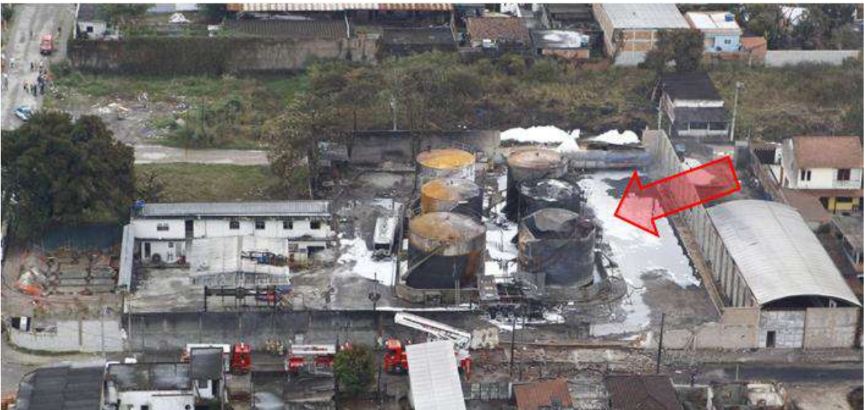
Figura 37 - Vista aérea do terreno com destaque para o tanque onde se iniciou o incêndio.
