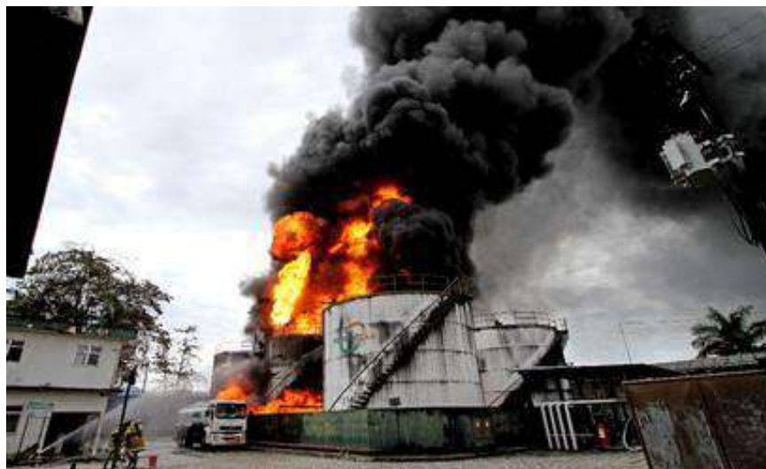
Figura 32 - Incêndio no dique.
