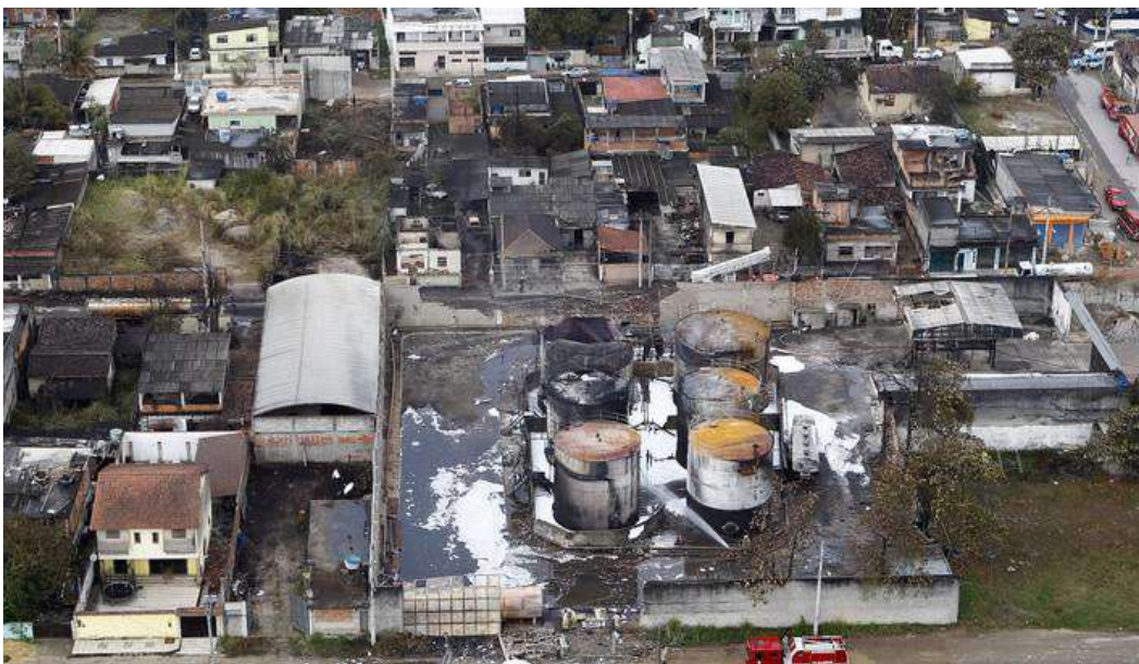
Figura 30 - Vista aérea do terreno após o acidente.
