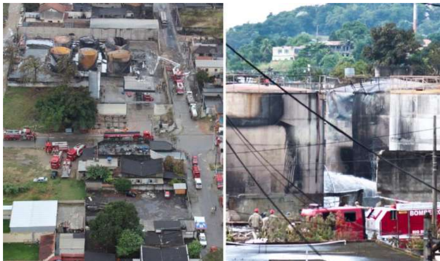
Figura 36 – Parque de tancagem da Petrogold após o incêndio ter sido extinguido.
