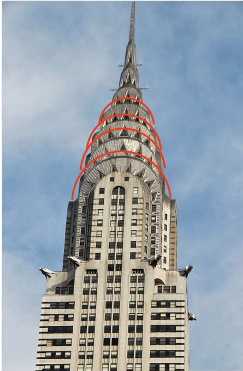
Figura 29 Análise de degraus em arco no topo do Chrysler Building Nova York. Fonte: Elaboração própria. Adaptado de https://www.filmabrasil.com/art-deco/
