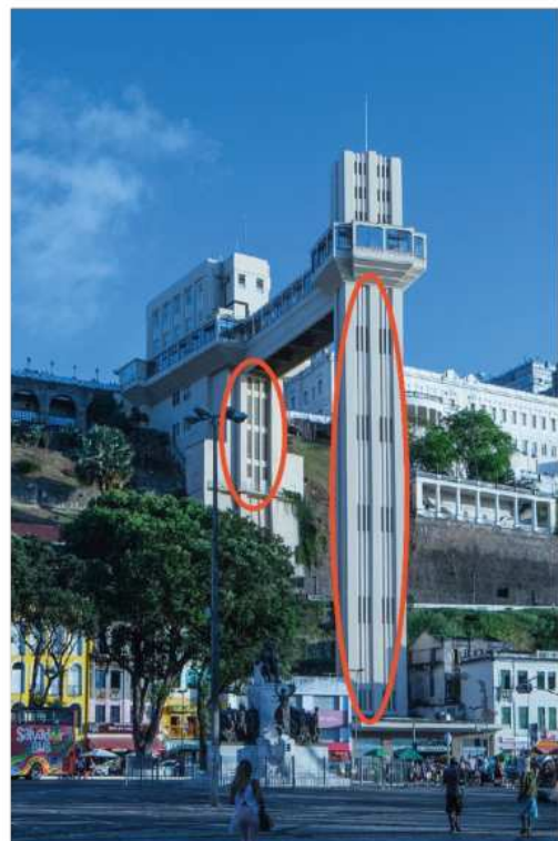
Figura 30 Destaque dos painéis e colunas no de-signer do elevador Lacerda. Fonte; elaboração própria. Adaptado de: https://pt.wikipedia.org/wiki/Elevador_Lacerda
