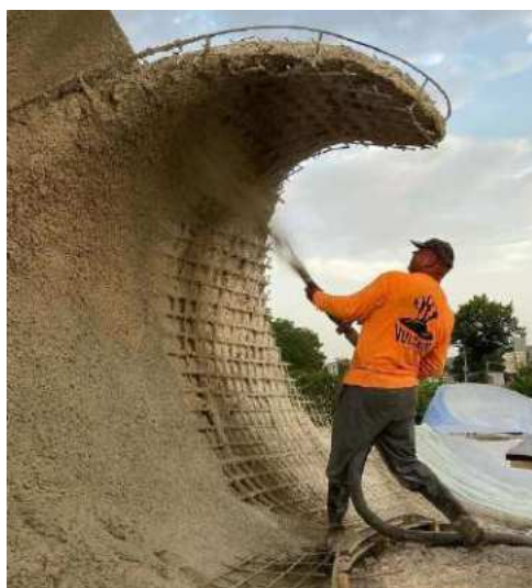
Figura 100: Construção de pista com concreto armado
