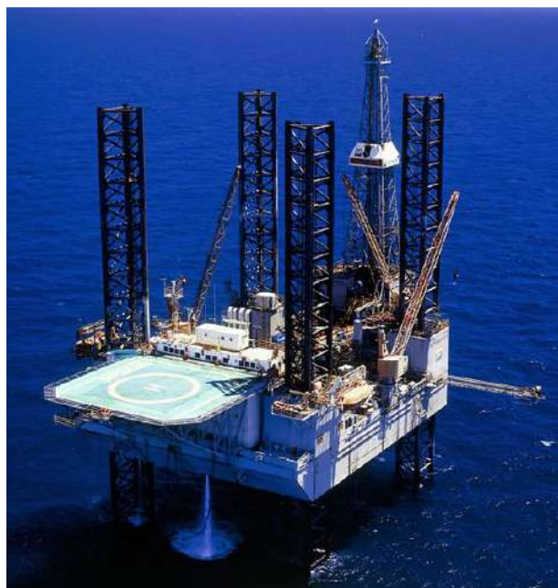
Figura 2.5 - Plataforma auto elevável P-5 operando no litoral do Rio Grande do Norte. Fonte: Banco de Imagens da Petrobras, 2015.
