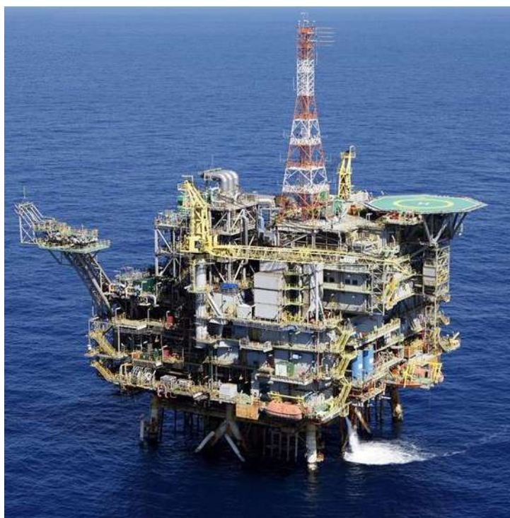
Figura 2.4 – Plataforma fixa de Mexilhão operando na Bacia de Santos. Fonte: Banco de Imagens Petrobras, 2015.
