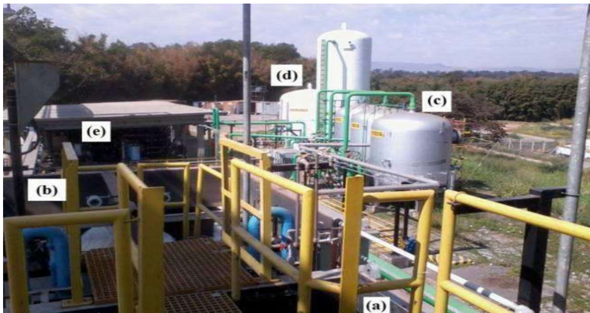
Figura IV.1: Unidade protótipo de reuso da Petrobras: (a) Clarificador Actiflo®; (b) Filtros de areia; (c) Filtros de CAG; (d) Tanques de carga da EDR; (e) EDR (Fonte: TOUMA, 2013).
