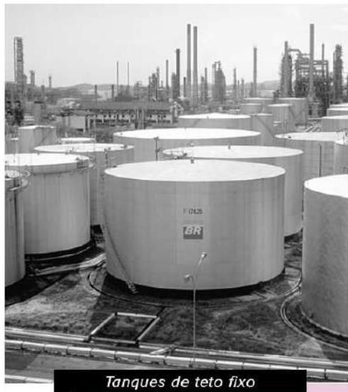
**Figura 4 - Tanque de Teto Fixo Plano. Fonte: SENAI – Apostila de Monitoramento de Controle de Processos [SIQUEIRA, 2010]**
