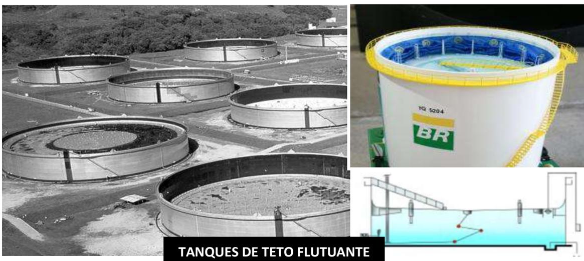
**Figura 5 - Tanques de Teto Flutuante. Fonte: SENAI - Monitoramento de Controle de Processos [SIQUEIRA, 2010]**
