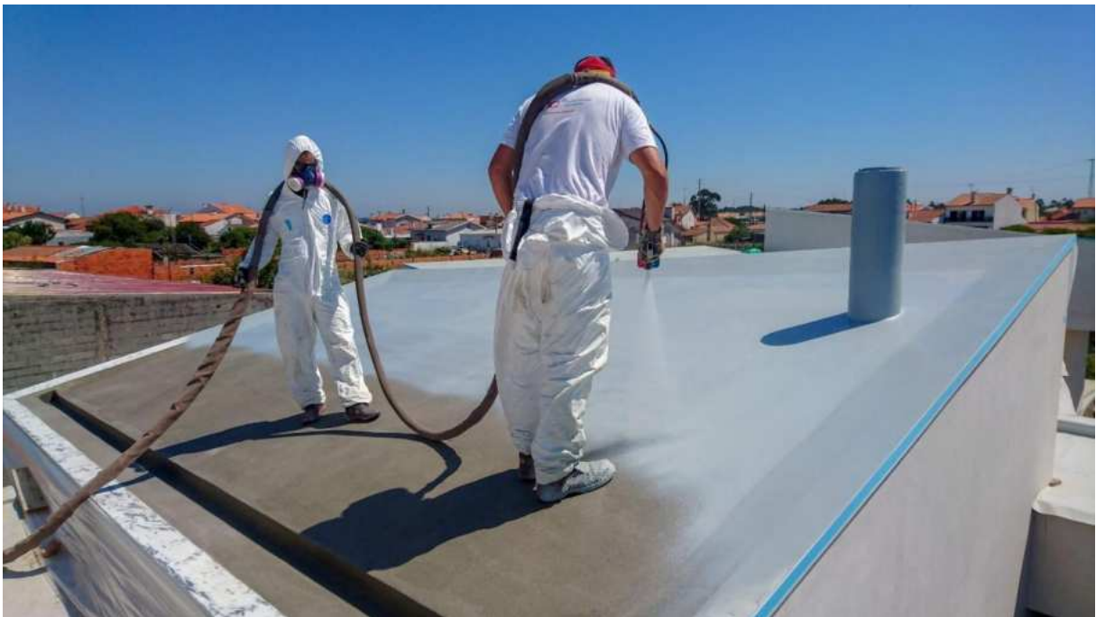
Figura 136 - Aplicação de poliureia. Fonte: https://vnc.com.pt/produtos-da-vnc/poliureia/
