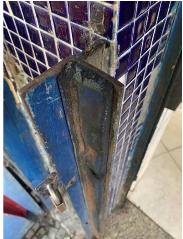
Figura 23 - Fixação de elastômero nos perfis presos à parede, comporta bar. Fonte: Elaboração própria
