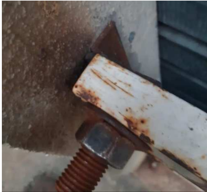
Figura 27 - Sistema de pressão com aparafusamento, arruela e porca, comporta papelaria. Fonte: Elaboração própria.
