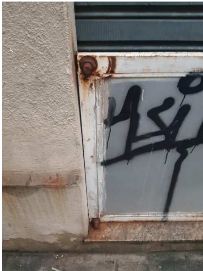
Figura 28 – Comporta instalada com sistema de pressão por aparafusamento em quatro vértices, comporta papelaria. Fonte: Elaboração própria.
