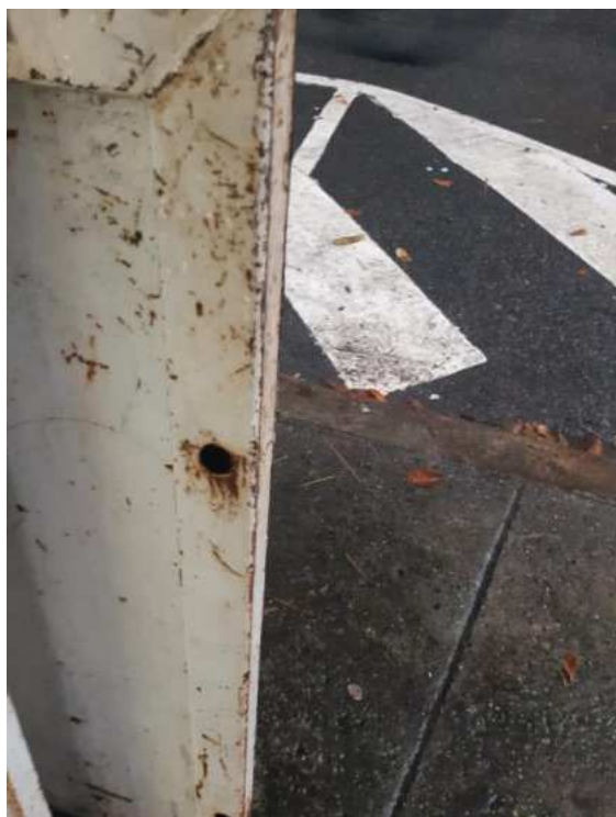
Figura 22 - Ponto de ferrugem na estrutura. Fonte: Elaboração própria.
