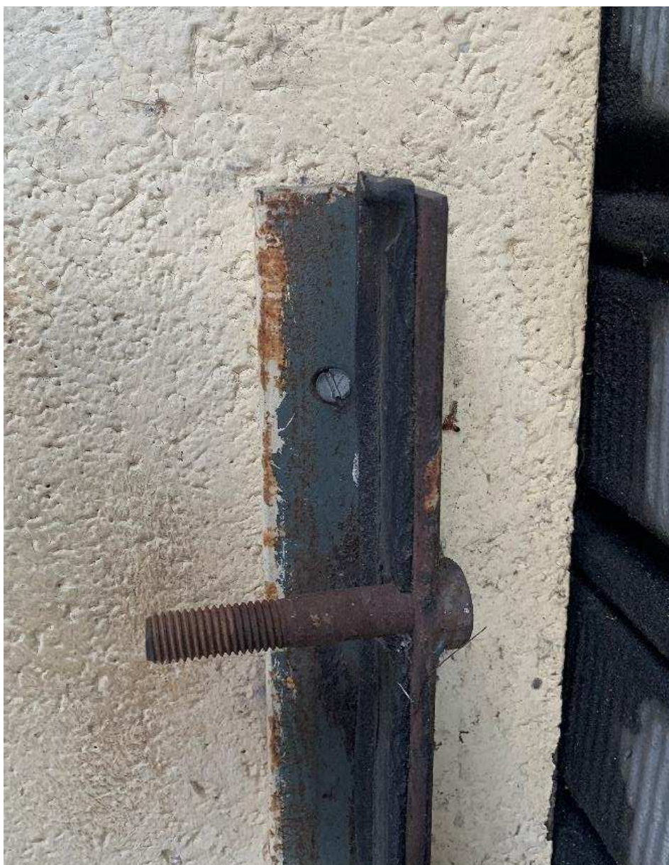
Figura 26 – Parafuso fixo no perfil, sistema de pressão com aparafusamento. Fonte: Elaboração própria.
