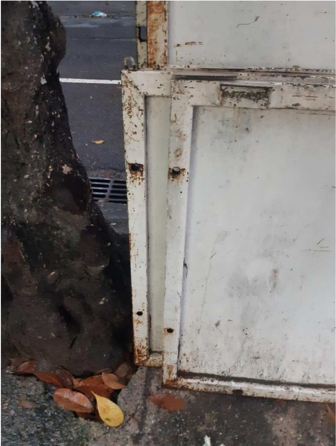
Figura 20 - Pontos de ferrugem, comporta da drogaria. Fonte: Elaboração própria.
