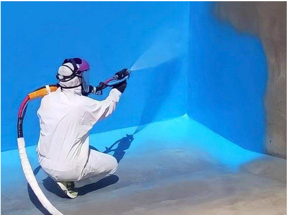
Figura 137 - Aplicação de poliureia com cor. Fonte: https://www.oimpermeabilizador.com.br/servicos_poliureia_poliuretano.php
