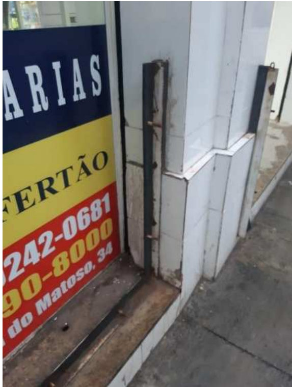
Figura 24 - Fixação de elastômero nos perfis presos à parede, comporta drogaria. Fonte: Elaboração própria
