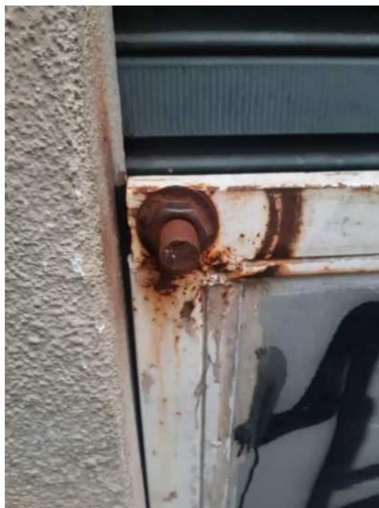
Figura 21 - Pontos de ferrugem no parafuso de pressão e moldura. Fonte: Elaboração própria.
