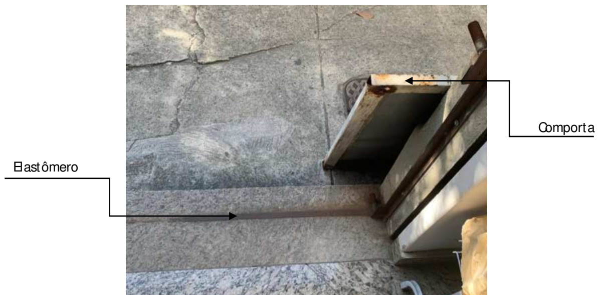
Figura 25 - Fixação de elastômero nos perfis presos à parede. Fonte: Elaboração própria.
