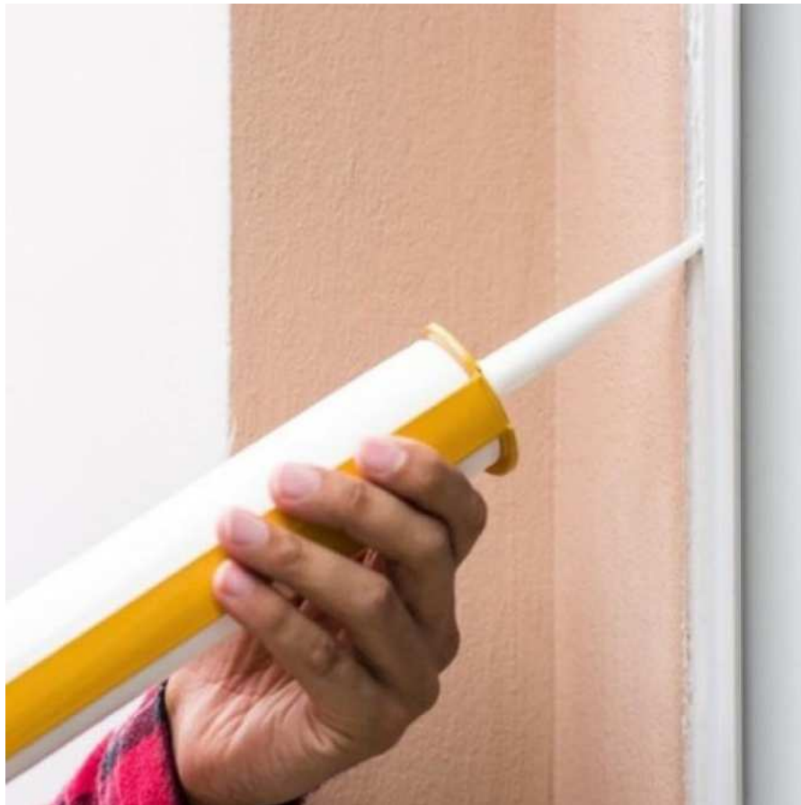
Figura 145 - Aplicação selante de PU. Fonte: https://www.rabeloparafusos.com.br/selante-pu-40-principais-aplicacoes/
