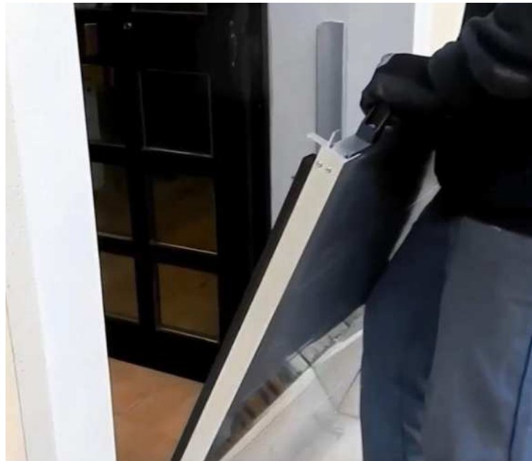
Figura 15 - Comporta com geração de pressão por encaixe, parte 01. Fonte: https://palexiberica.com/producto/tritone/
