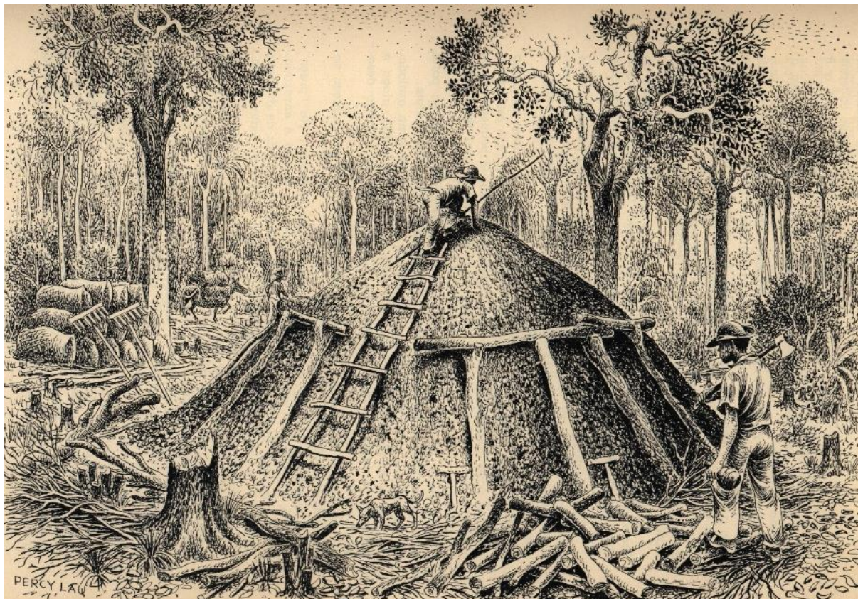
Figura 1: Carvoaria em operação (tipo balão de carvão), feita em área plana. Nanquim de Percy Lau. Fonte: IBGE, 1966.
