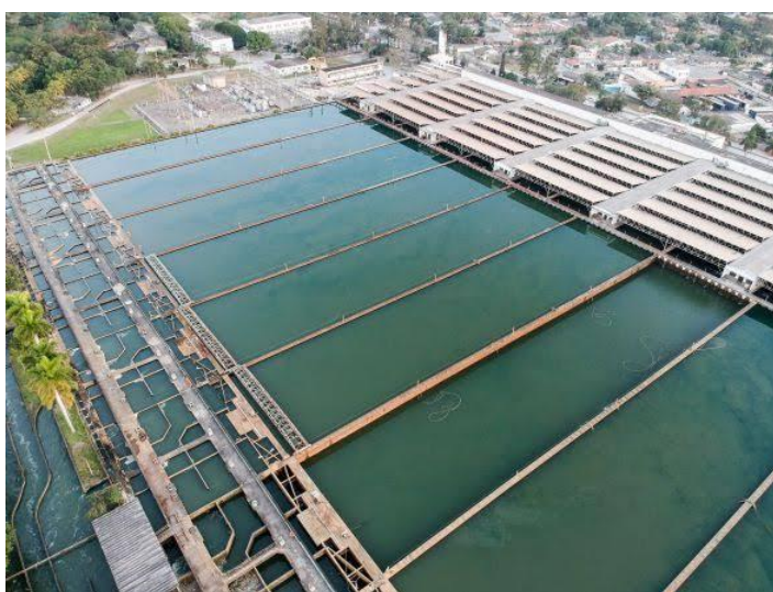
Imagem 1 - Sistema elevatório de água do Sistema Guandu.
